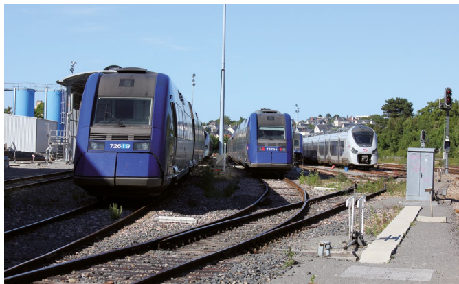
Atelier de maintenance de Granville. Ancien et nouveau matériel, le 7 juin 2015
