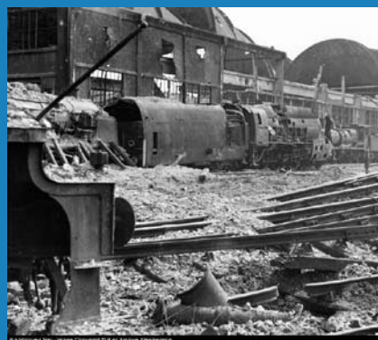
Le dépôt des locomotives de Caen
