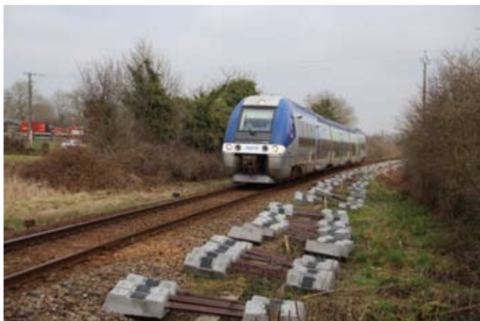
Préparation chantier RVB PN 32 (10 02 2017)
