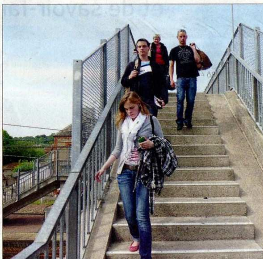
Difficile d'escalader cette paroi de béton lorsqu'on est chargé ou que l'on éprouve des difficultés pour se déplacer...
