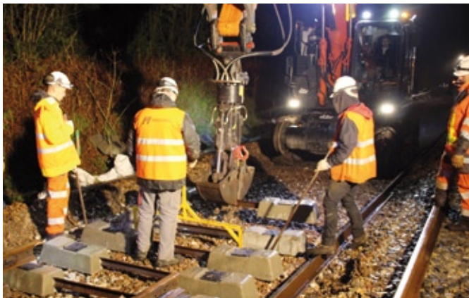
Travaux de renouvellement de voie entre Belval et Coutances, le 26 avril 2017.
