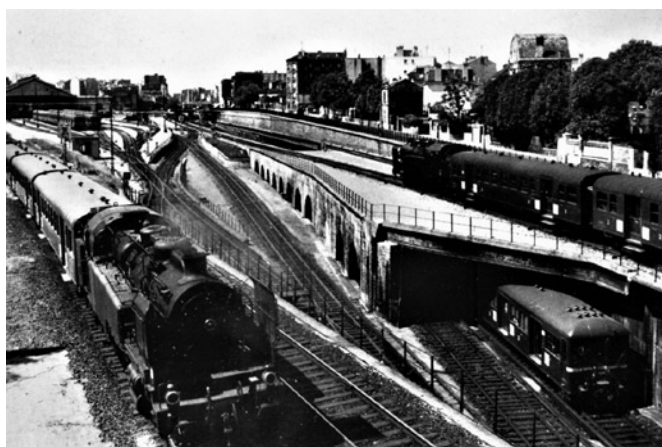
Le Saut de Mouton d'Asnières au temps de la vapeur. A gauche la ligne de Poissy, à droite celle de Conflans-Sainte-Honorine au centre la ligne d'Argenteuil qui passe sous les deux autres.
