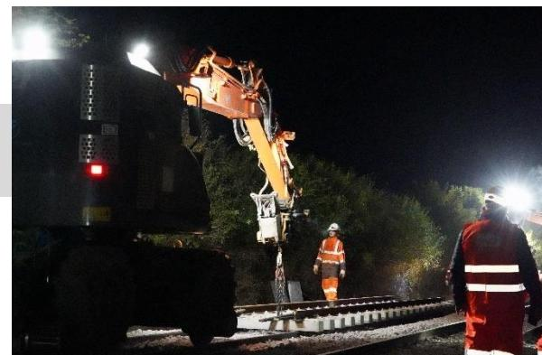
Un engin dépose les panneaux de voies avec les traverses et les rails déjà assemblés.
